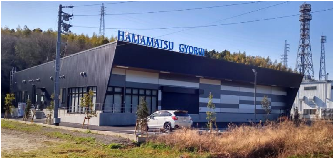
▲ 商材の持続的な供給を可能とする大久保工場
