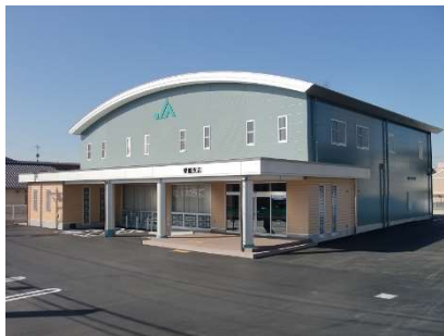
建設事業 (金融機関店舗)
