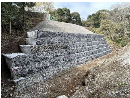
駒瀬川の雨水貯留地進入路の法面復旧工事
