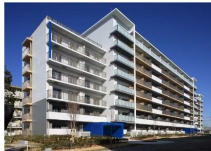
PFI事業 (県営住宅今沢団地)
