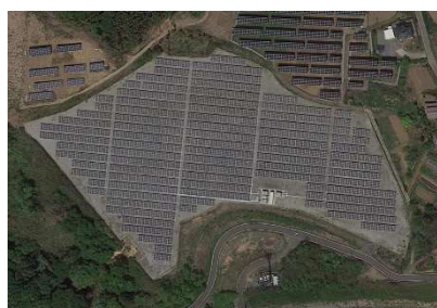
黒熊発電所（群馬県高崎市）
