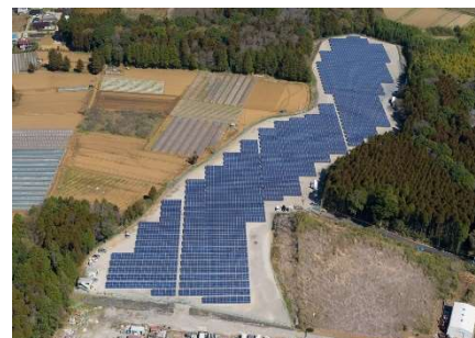
自然エネルギー事業 (八街市太陽光発電設備)
