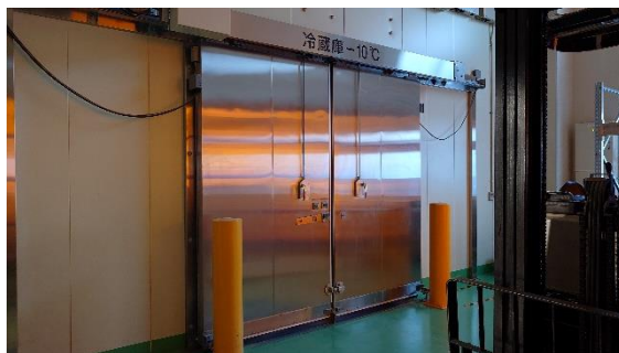
▲庫内が温度毎に分かれた冷気が漏れにくい冷蔵倉
